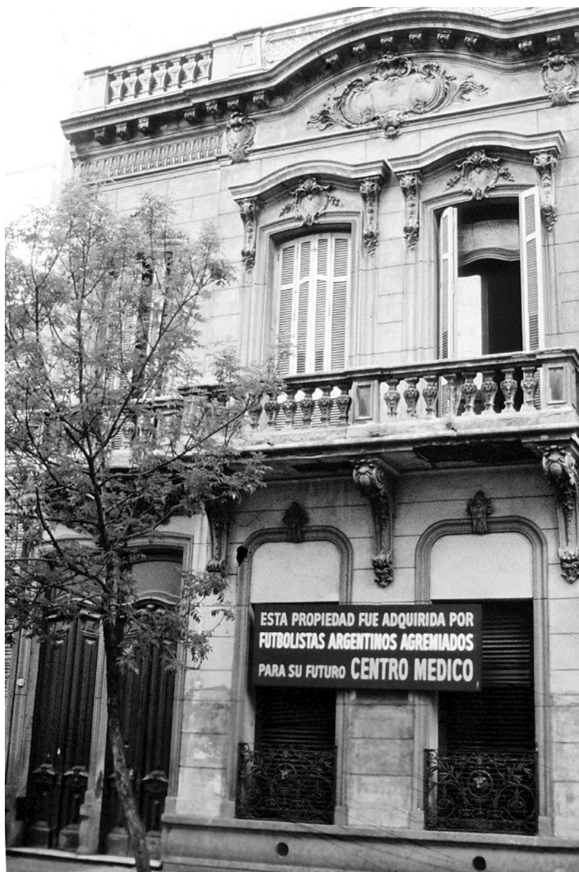
Fachada del edificio original de la calle Salta.
